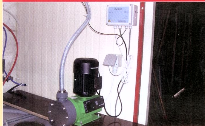
▲ Modèles allant de 50 l/heure à 375 l/heure. NB: soucis d'usure avec les pompes doseuses mécaniques (piston, ressorts), débit inadapté des pompes électriques, problème avec les pompes à air comprimé lorsqu'elles sont très sollicitées.
